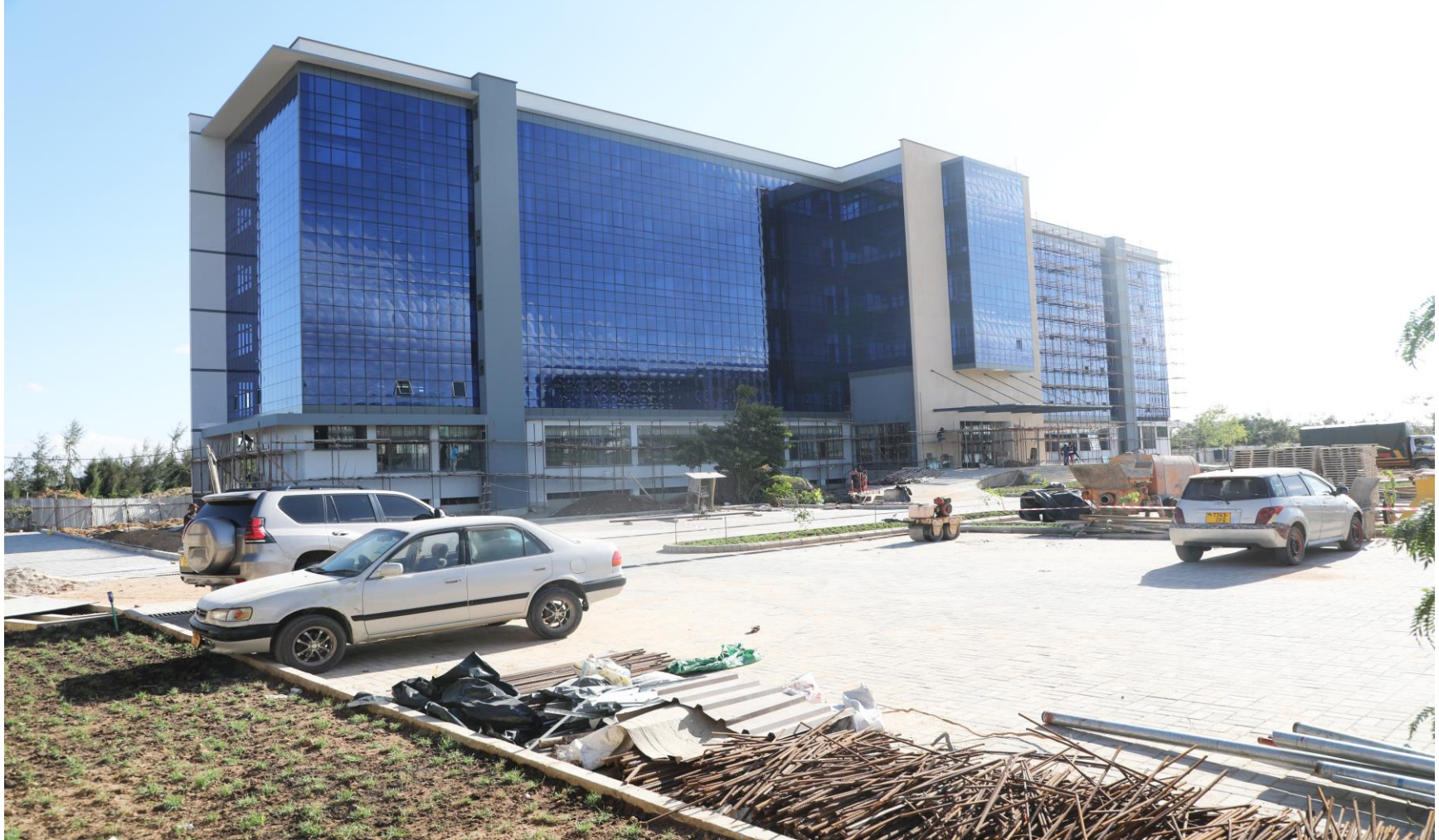
Ujenzi wa Jengo la Ofisi ya Wizara ya Maliasili na Utalii ukiendelea katika Mji wa Serikali – Mtumba, Dodoma.
